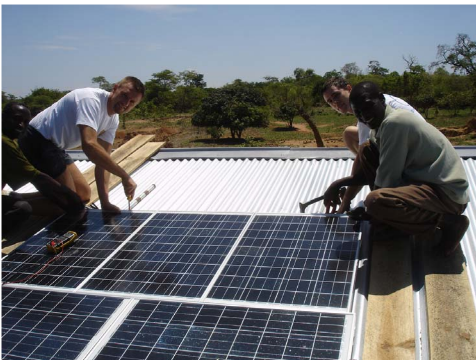
Montage des panneaux sur le toit
