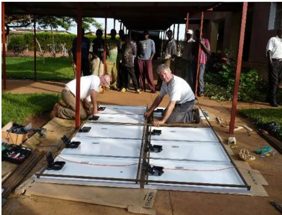
Johan Baert et Axel Lefèvre montent les panneaux photovoltaïques
