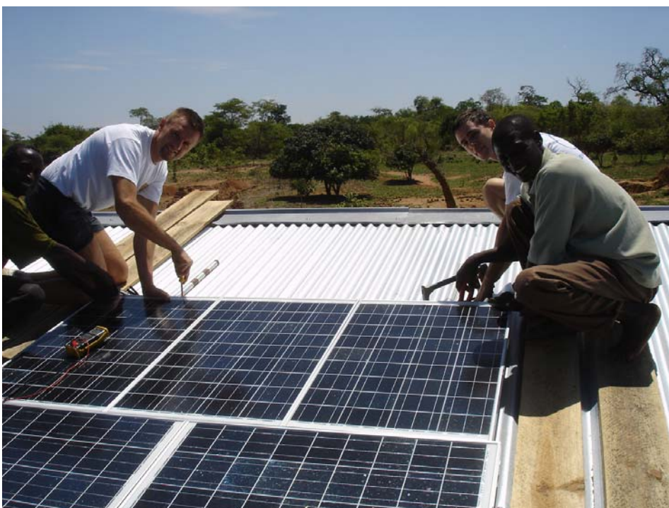
Het vastmaken van de panelen op het dak
