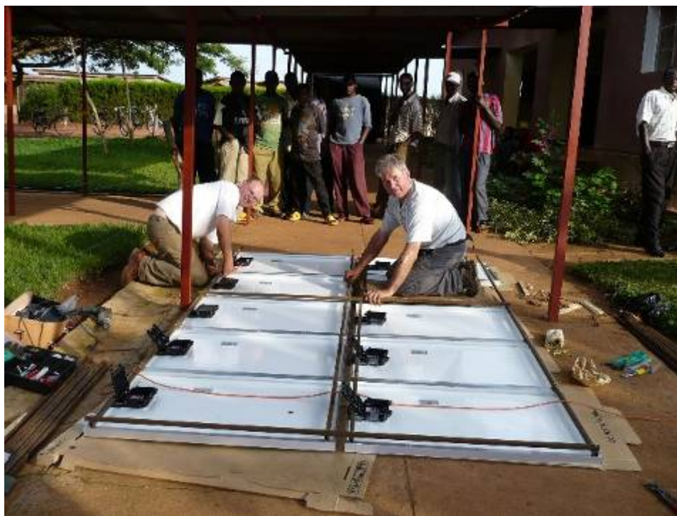
Johan en Axel zetten de fotovoltaïsche panelen in elkaar
