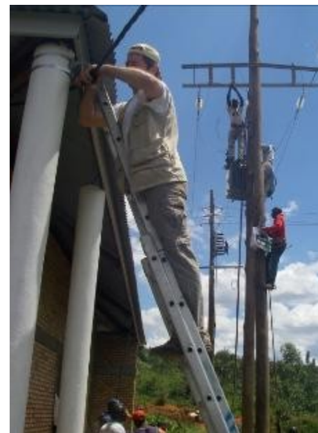
Jacques sluit samen met de lokale medewerkers de transformator aan
