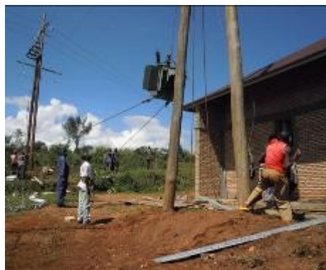
De lokale creativiteit om de transformator boven op de paal te krijgen
