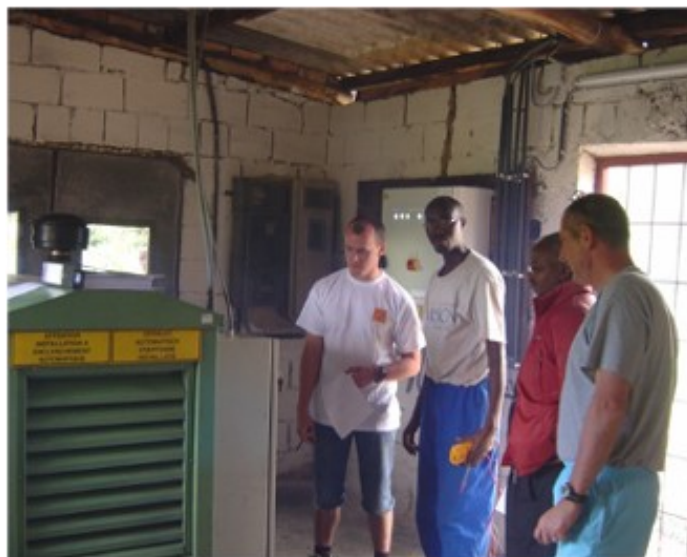
Bart en Jean-Claude leggen de werking van de stroomgenerator uit
