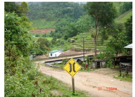
Algemeen zicht op de site met op de voorgrond de brug en het gebouw van de turbogenerator
