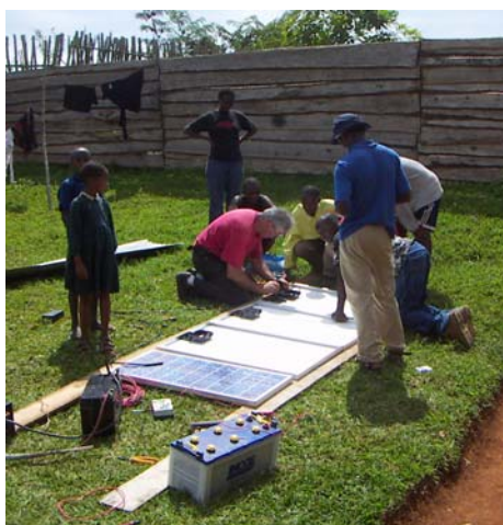
Montage van de zonnepanelen
