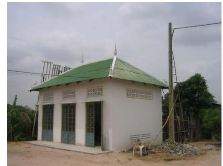
De nieuwe elektriciteitscentrale
